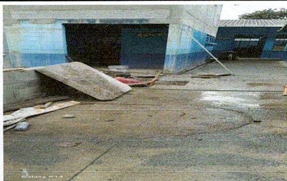
Foto 3: Mejoramiento de módulo de Baños, Drenaje y Fosa Séptica.
