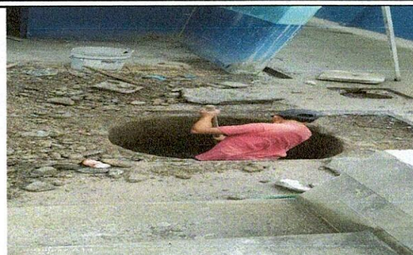
Foto 2: Mejoramiento de módulo de Baños, Drenaje y Fosa Séptica.
